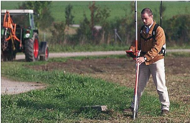
Anschließend werden die Messtrupps des Amtes für Ländliche Entwicklung Oberfranken die Grenzsteine und die mit Pflöcken gekennzeichneten topographischen Objekte vermessen.
