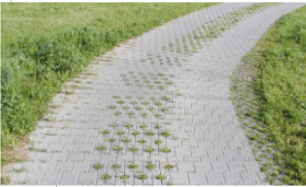
Bautyp 4ak Betonverbundsteine mit Rasengittersteinen mittig
